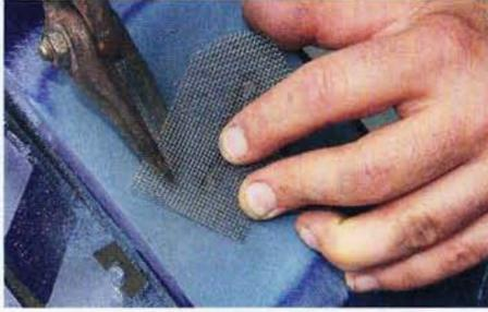
Aus Edelstahl-Gewebe wird ein Flecken zugeschnitten, der die Schadstelle überspannt
